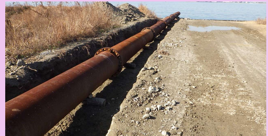
海岸工事の排砂管(株式会社小林組HPより)
