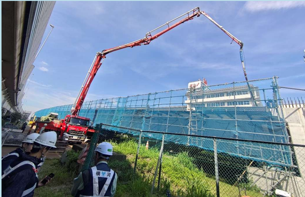
合成床板打設工事の様子(丹羽撮影)
